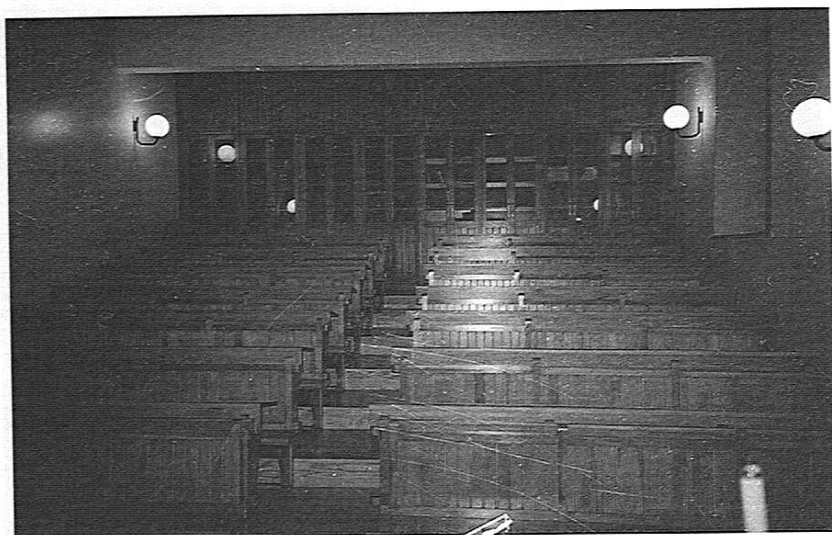
Instituto "Mariano Quintanilla". Aula "Antonio Machado". Estado actual.
