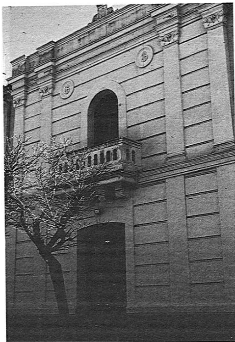
Instituto "Mariano Quintanilla". Fachada principal al oeste. Eje lateral de entrada al Instituto. Estado actual.
