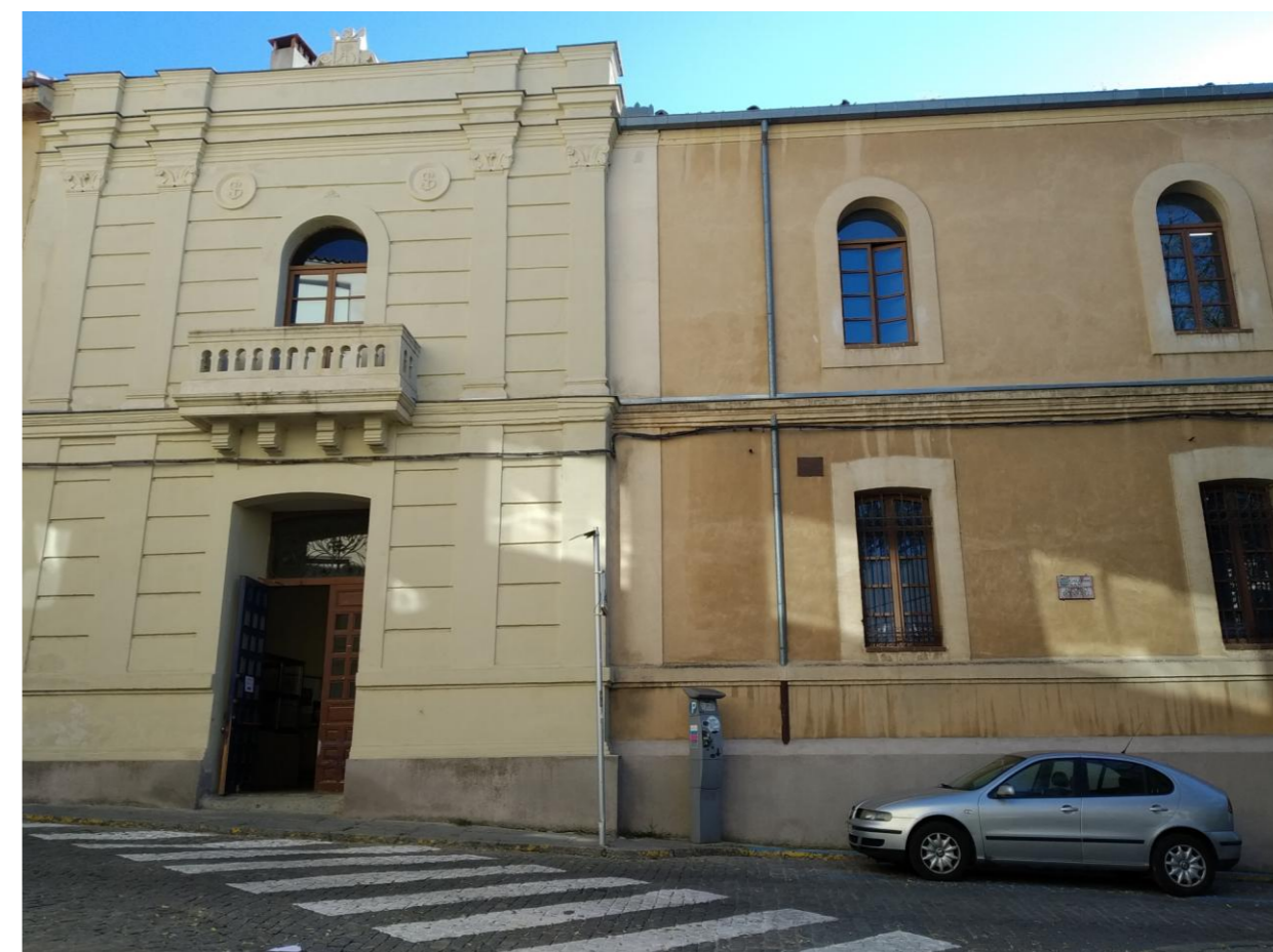
Entrada al instituto por la calle Ochoa Ondátegui, por donde se entraba a la Biblioteca Provincial. Las ventanas que se ven de la planta baja pertenecen al espacio donde estuvo ubicada.
