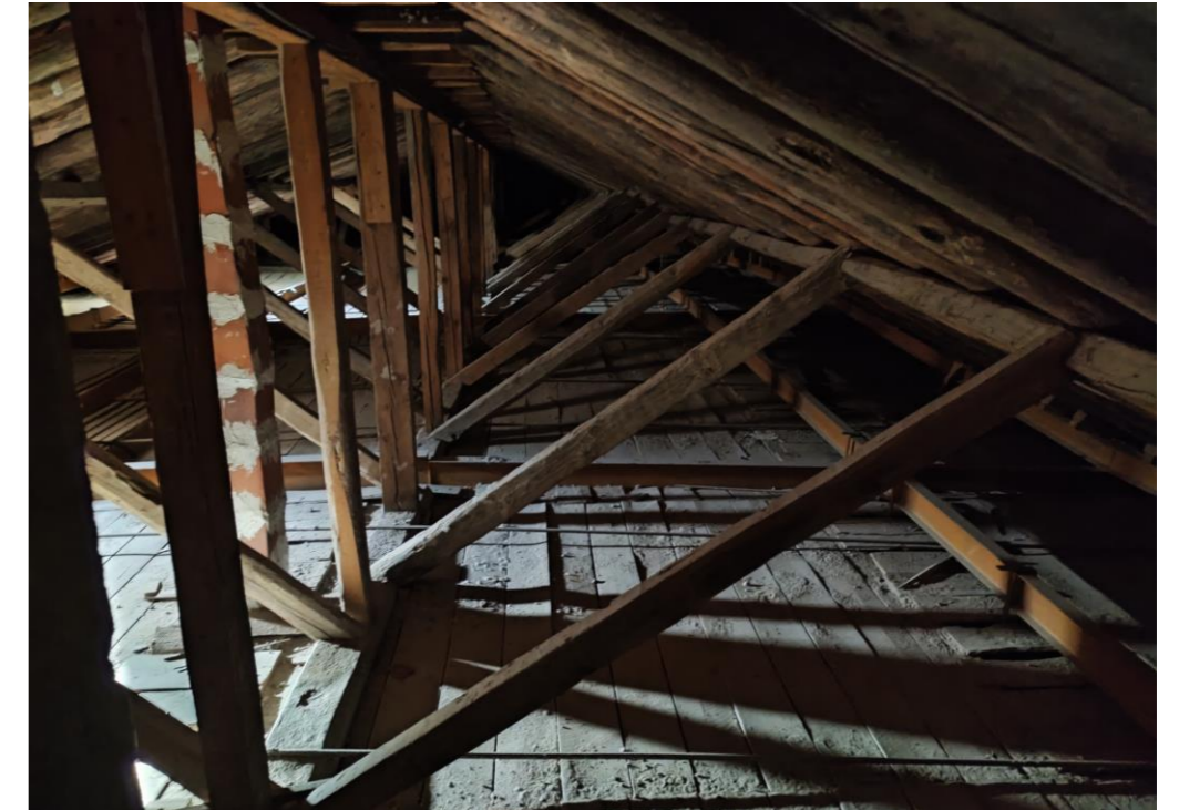
Interior de la techumbre
